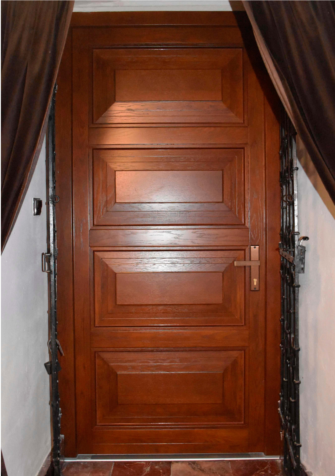
Nowe drzwi z holu do ogrodu w siedzibie TNP przy pl. Narutowicza 8 zamontowane w ramach realizacji IV etapu zadania Prace konserwatorskie i restauratorskie przy wymianie stolarki okiennej i drzwiowej gotyckiej XV-wiecznej kanonii – siedziby Towarzystwa Naukowego Płockiego w Płocku współfinansowanego ze środków Samorządu Województwa Mazowieckiego
