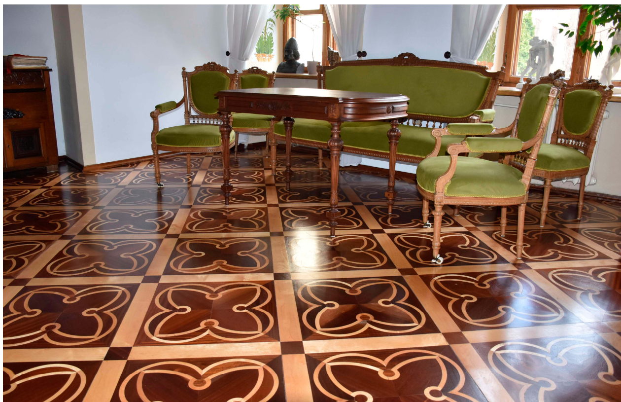
Salonik im. Gustawa Zielińskiego w budynku TNP po remoncie – malowaniu ścian oraz cyklinowaniu i lakierowaniu podłogi
