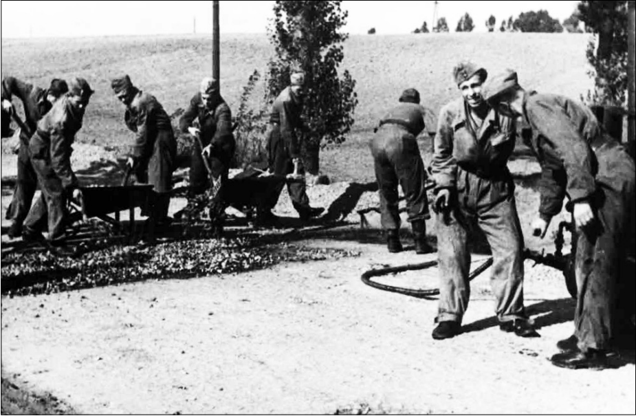
Fot. 23. Żołnierze 63 batalionu mostowego podczas budowy nawierzchni bitumicznej na drodze Płock–Bodzanów (1954 r.)
