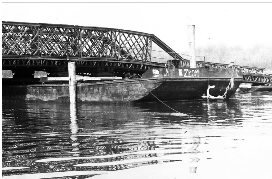
Fot. 34. Plac ćwiczeń Dobrzyków. Nowatorska konstrukcja mostu kombinowanego (1985 r.)
