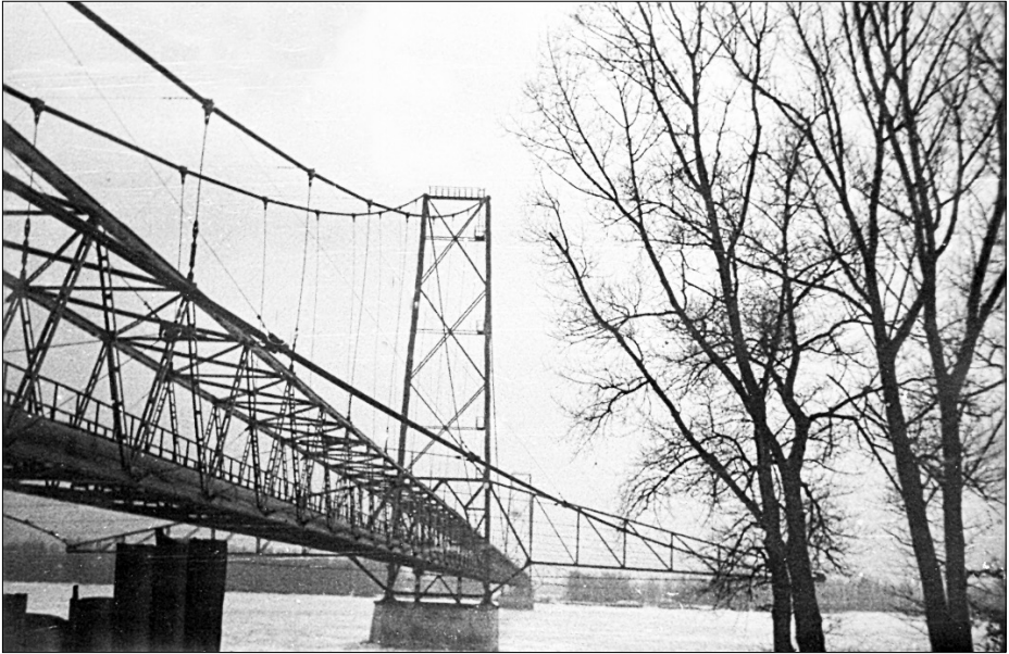
Fot. 31. Demontaż mostu wiszącego rurociągu „Przyjaźń” (1986 r.)
