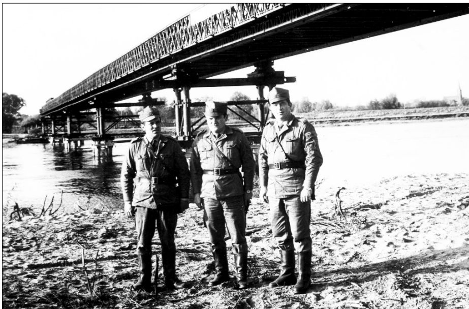
Fot. 33. Most przez Odrę w rejonie Cedyni wybudowany przez żołnierzy 3 Warszawskiego pułku mostowego podczas ćwiczenia „Bariera-79” (1979 r.)
