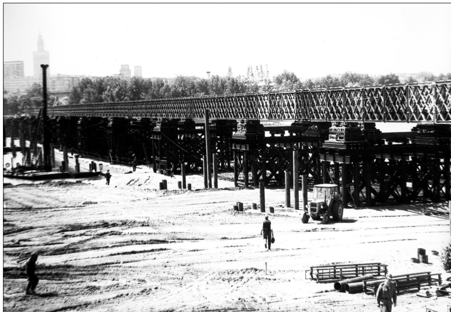
Fot. 29. Ostatni etap budowy mostu Syreny (1985 r.)
