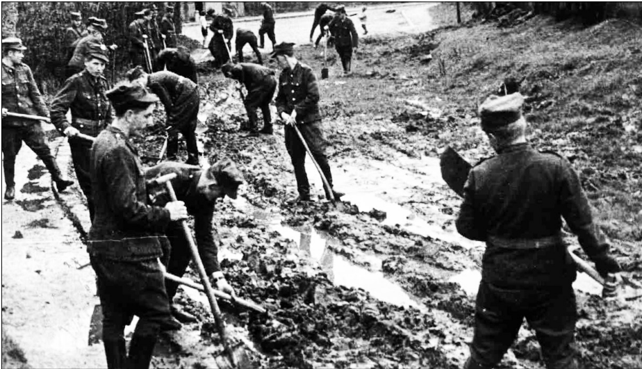
Fot. 24. Pierwsze prace na przyszłym osiedlu Tysiąclecia w Płocku (1961 r.)
