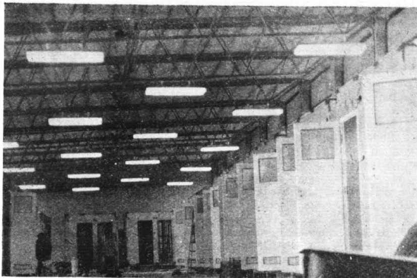
Hala produkcyjna prefabrykowanych kabin sanitarnych dla budownictwa mieszkaniowego. Wybudowana w 1971 r. przez PBP „Petrobudowa” kosztem 3,5 mln zł o zdolności produkcyjnej 1.000 kabin rocznie.
