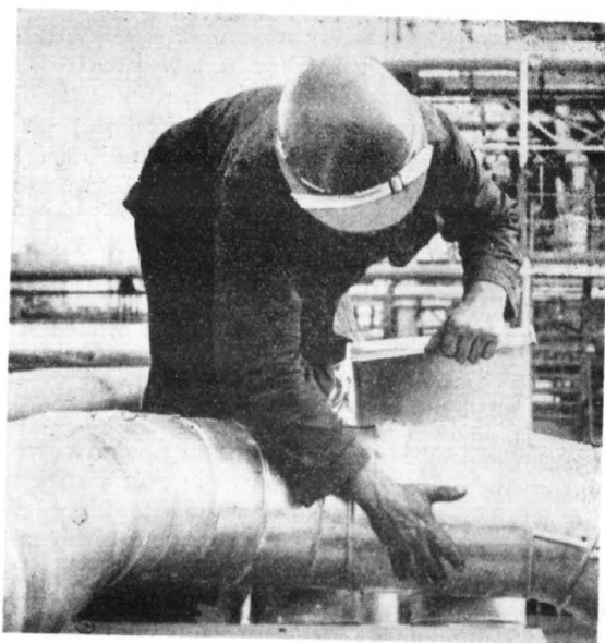
Montaż izolacji ciepłochronnej rurociągu doprowadzającego parę do instalacji butadienu.
