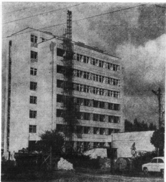
Fabryka aktualnie jest wielkim placem budowy, wznoszone są nowe hale produkcyjne, rozbudowywane jest zaplecze socjalne. Na zdjęciu: Centrum administracyjne w budowie — dwie kondygnacje zajmie Elektroniczny Ośrodek Obliczeniowy.
