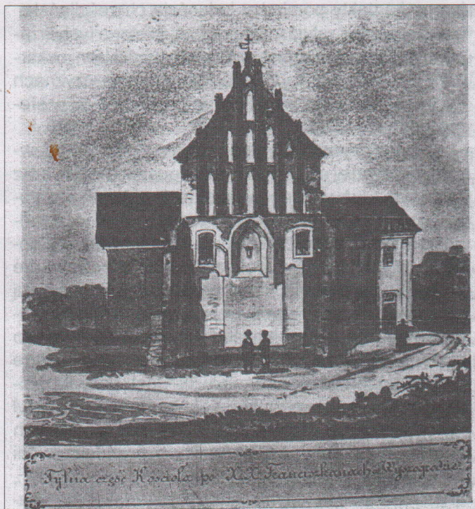
Tylna część Kościoła po Franciszkanach w Wyszogrodzie
