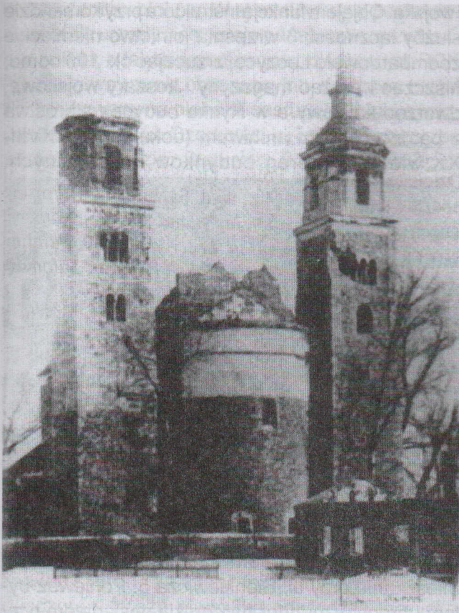
Fot. 1. Zniszczona archikolegiata
