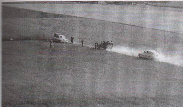
Geodeci na przyszłym placu budowy Kombinatu
