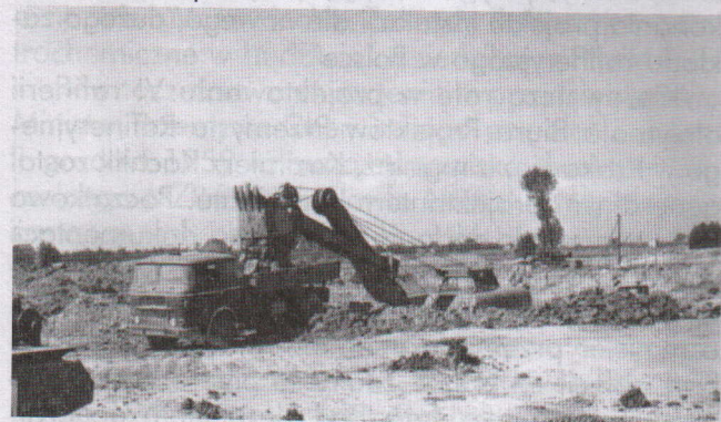
Pierwsze prace ziemne na placu budowy MZRiP
