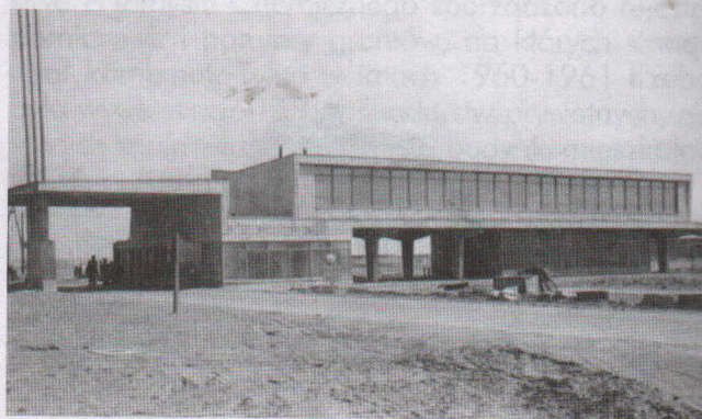
Budynek portierni i Bramy nr 1 w budowie
