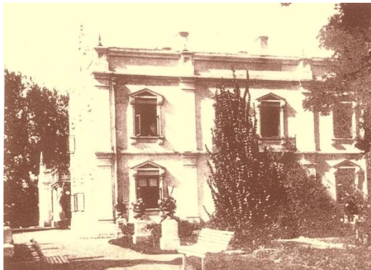
193. Dwór w Łazach, przybudówka, fasada boczna. Z lewej strony widoczny front dworu. Stan z przed II wojny światowej.
