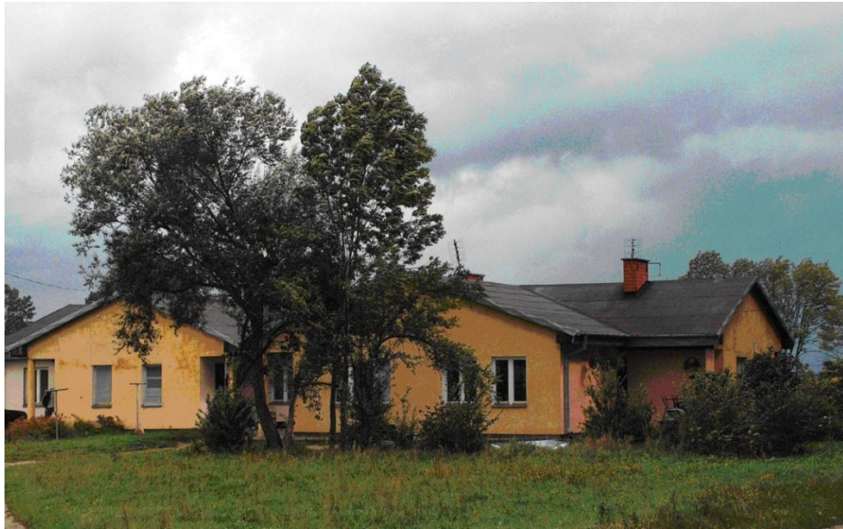
210. Ogólny widok domu wybudowanego przez p. M. Karnkowską. Stan z 2006-09-04.
