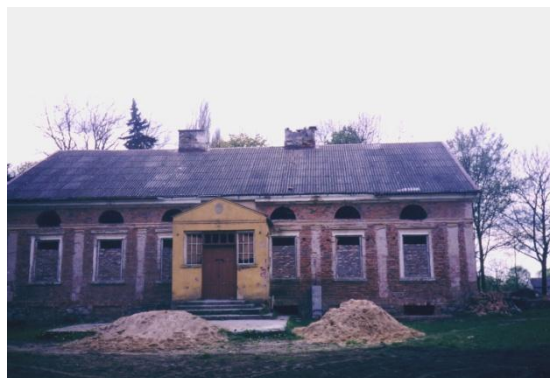
255. Dwór w Olesznie, elewacja frontowa. Stan prac rekonstrukcyjnych z dnia 2002-04-28.
