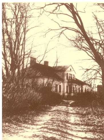
290. Dwór w Paskach, przed rozpoczęciem remontu. Ujęcie 2.
