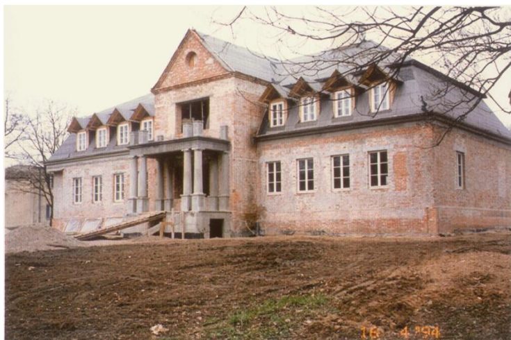
289. Dwór w Paskach, po zakończeniu remontu, stan surowy. Elewacja od strony ogrodu. Z lewej strony w tyle widoczny budynek dla gości i personelu.
