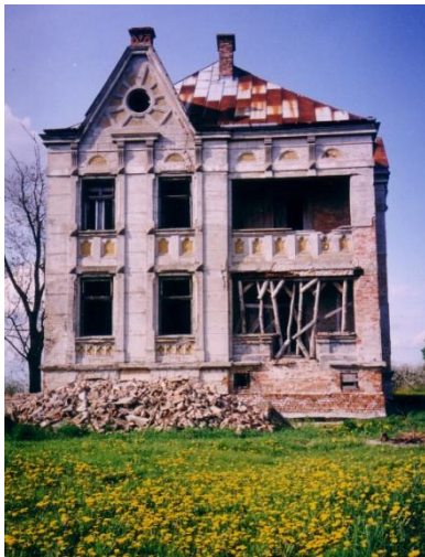
417. Dwór w Zarzeczewie, postęp prac budowlanych stan z 2002-04-28.
