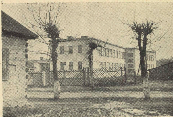
Nowa szkoła 7-klasowa w Mordach
