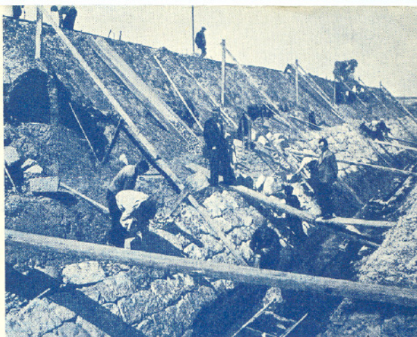
Budowa obrzeża Nr 2 w basenie III.
