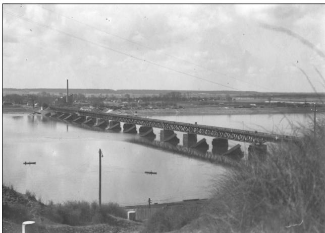
Most w Płocku drewniany przed 1936 r.
